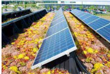
Afbeelding 2.3.16 - groendak in combinatie met PV panelen.
