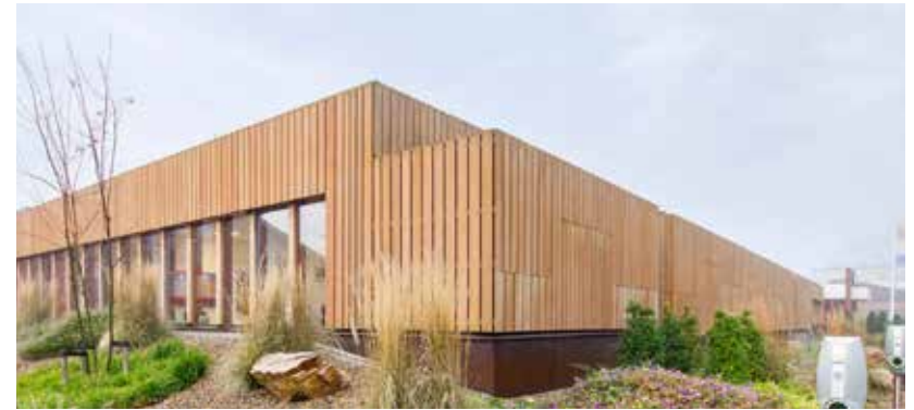
Afbeelding 2.3.18 - kantoren en spreekkamers in laagbouw met houten gevelafwerking en grote puien.
