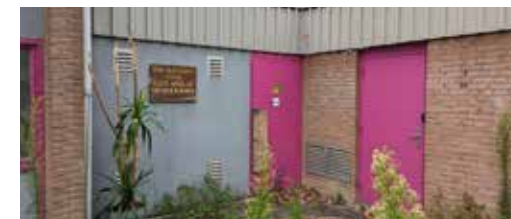
Afbeelding 2.1.8 - Meterkast water en gas aansluiting op de binnenplaats
